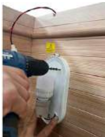
(15) Folosiți șuruburi pentru a fixa capacul luminii de saună (șuruburi de 3,5x25 mm 2 bucăți)
