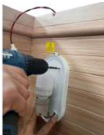
(15) Schrauben zur Befestigung der Saunalichtabdeckung verwenden (3,5x25mm Schrauben 2 Stück)
