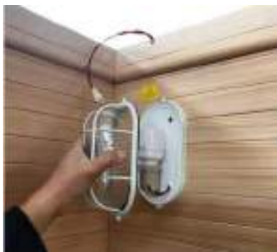
(16) Instalați capacul impermeabil al luminii de saună (șuruburi 4x12mm)
