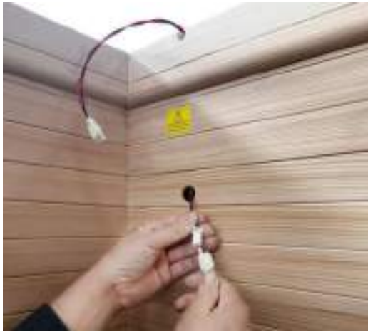
(14) Saunalichtkabel wie oben anschließen.
