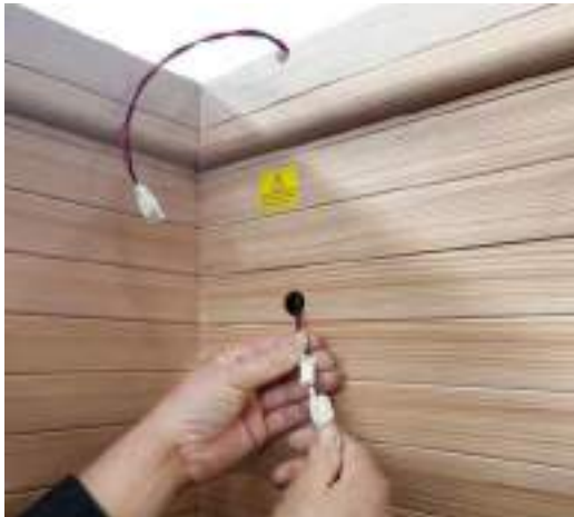
(14) Conectați cablul de lumină pentru saună ca mai sus.
