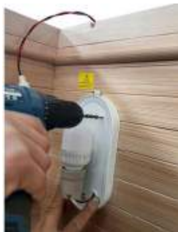
(12) Schrauben zur Befestigung der Saunalichtabdeckung verwenden (3,5x25mm Schrauben 2 Stück)
