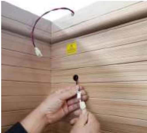
(11) Saunalichtkabel wie oben anschließen.
