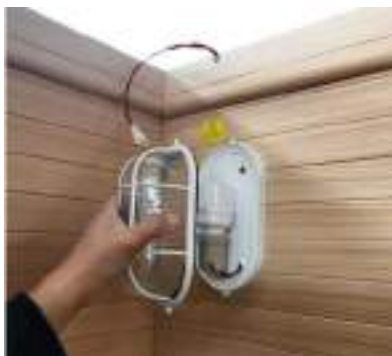
(14) Installieren Sie die wasserdichte Abdeckung des Saunalichts (4x12mm Schrauben)
